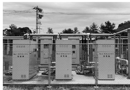
【下水道消化ガス発電】
